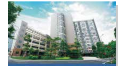
Edificio de apartamentos de formación
