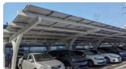
Cochera fotovoltaica impermeable
