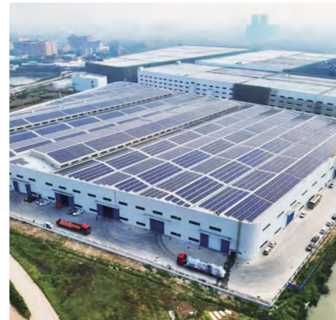
Estación de Energía Solar en Techo Haitian
