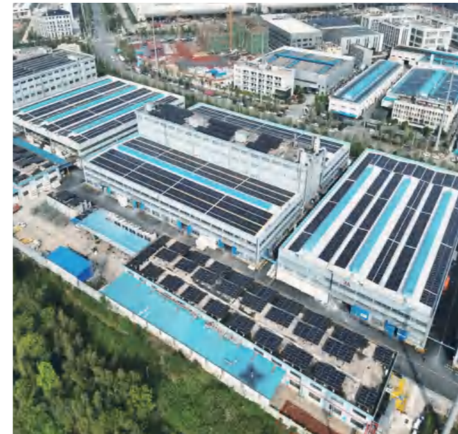
Estación de Energía Solar en Azotea de Changsha
